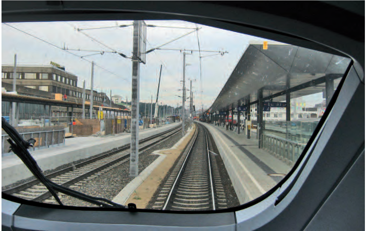
Blick aus dem Neigetechnik-ICE auf die Bahnhofsbaustelle St. Pölten
