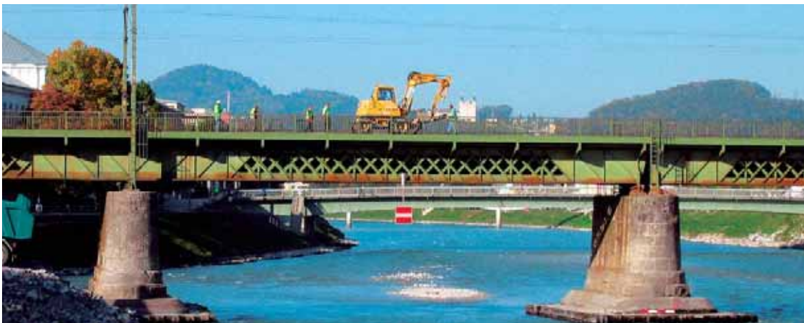
Neubau der Salzach-Brücke in Salzburg
